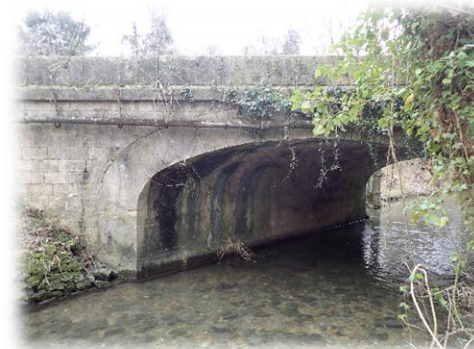
Ouvrage hydraulique de la RD31 Petit Fusain à Courtempierre favorable avec présence avérée
