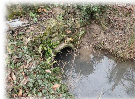
Ouvrage hydraulique de type buse non favorable aux chiroptères
