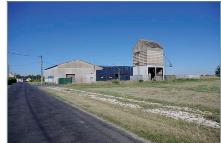
FIGURE 15: Silos et Hangars à Sceaux-du-Gâtinais
